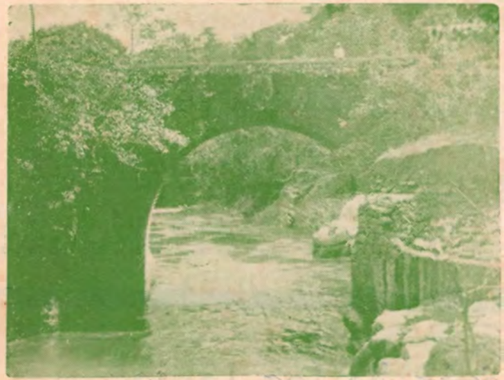
Puente de mampostería sobre el Río Grande de San Ramón
